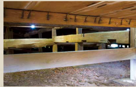
大澤寺本堂床下のほぞ穴を開けた木材
