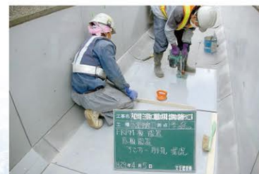
▲老朽化した水路の補修作業
