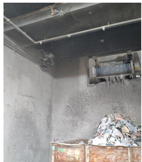
左上部奥に温度センサーが、廃棄物がストックされるエリアの天井にはスプリンクラーが設置されていることが確認できる。
