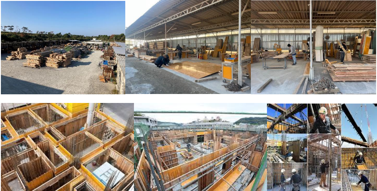
(出所：篠原建設)
