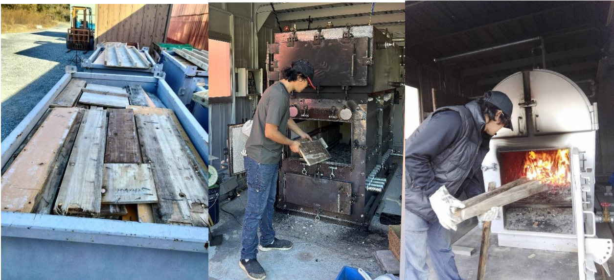
(出所：篠原建設)
