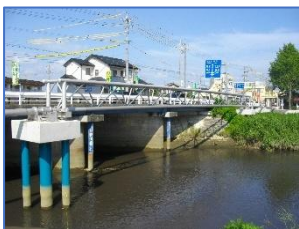
芳川橋水管橋外 3 橋耐震診断・実施設計（2010 年）
