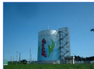
牧之原配水池築造工事設計（2003 年）
